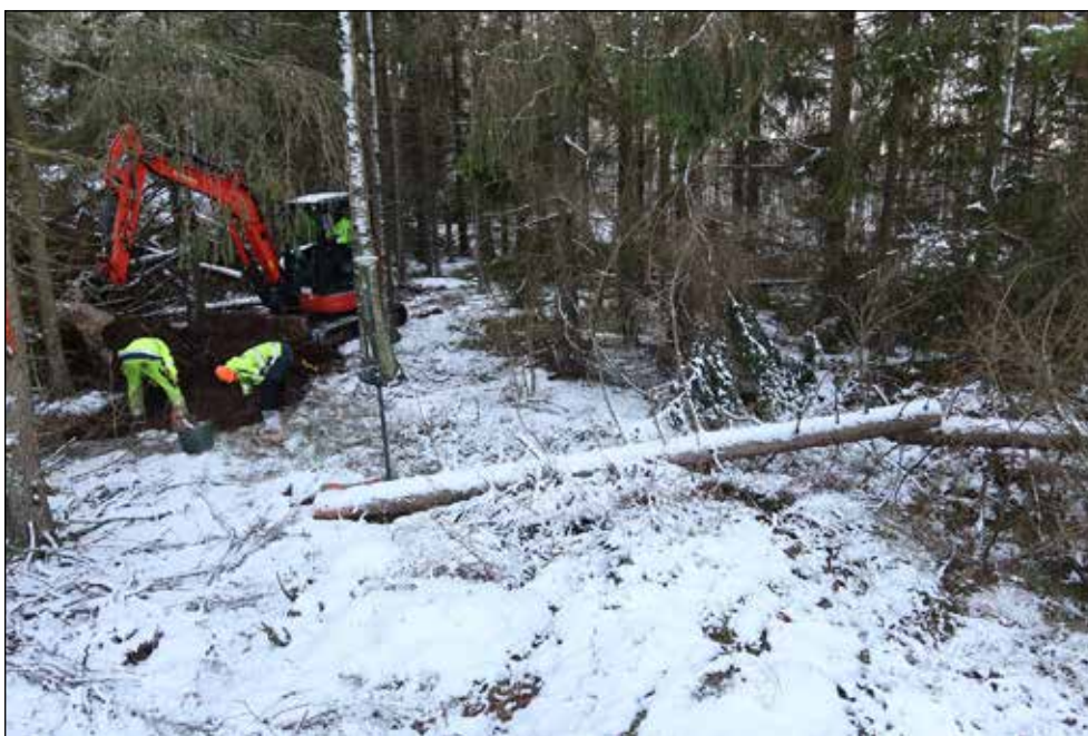
Figur 48. Boplatsen L2021:2615 avgränsades mot bronsålderssundet endast genom ett lägre berg, som här ses till vänster i bild. Foto mot sydost.
